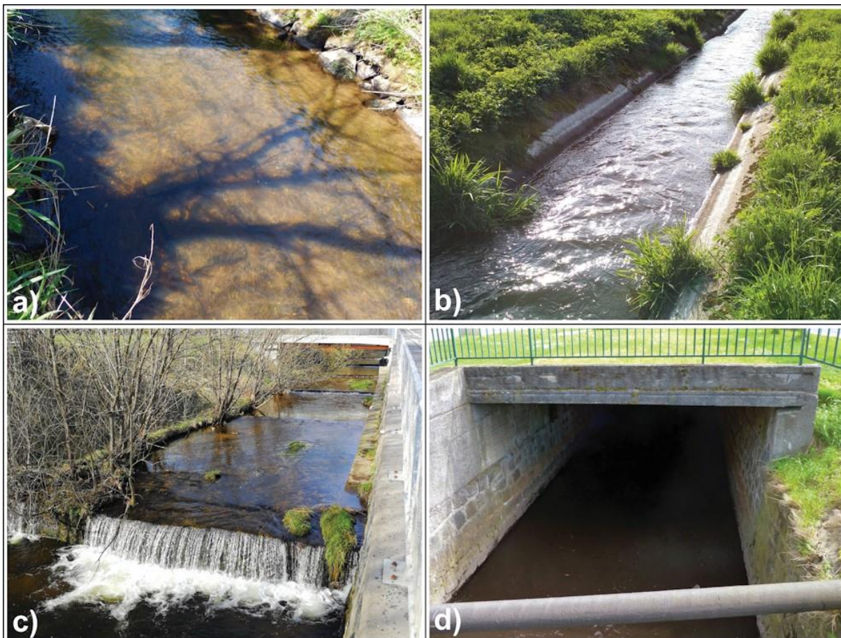
Obř. 41: (a) stabilizace dna koryta pomocí kamenné dlažby; (b) stabilizace břehů a dna betonovými panely představují tvrdý typ stabilizace; (c) stabilizační stupně a prahy významným způsobem mění morfologii dna koryta; (d) zakryté vodní toky nejsou schopny plnit ekologické funkce
