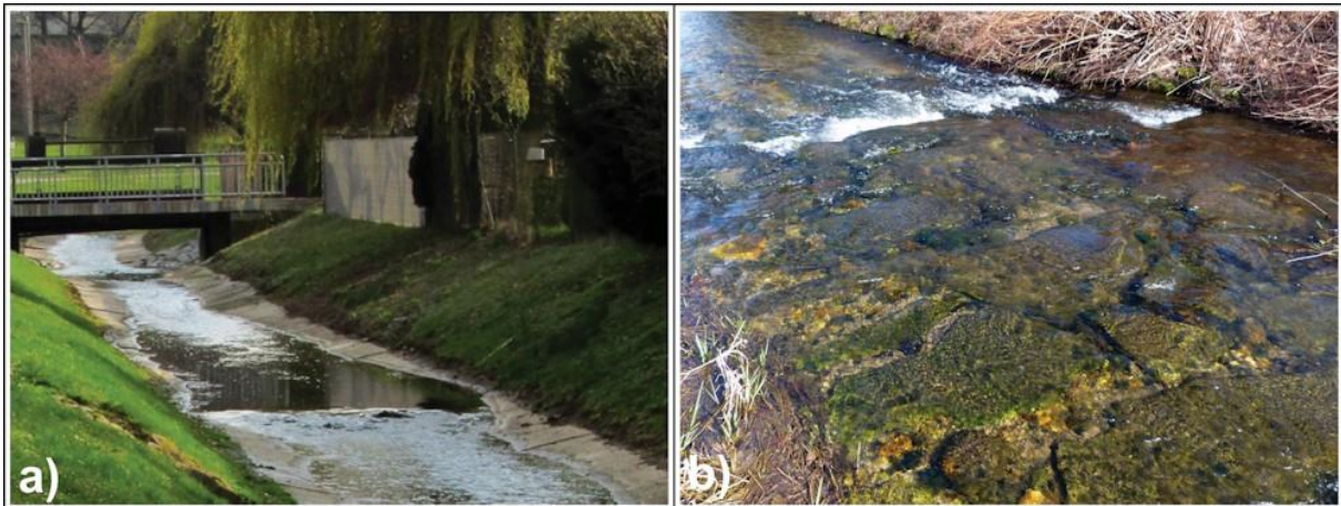
Obr. 13: (a) betonové panely tvoří nepropustnou vrstvu, která narušuje vertikální kontinuitu; (b) ačkoliv kamenná dlažba bez pojiva významně mění charakter dna, není nepropustným typem stabilizace, tzn. dochází jenom k částečnému narušení vertikální kontinuity
