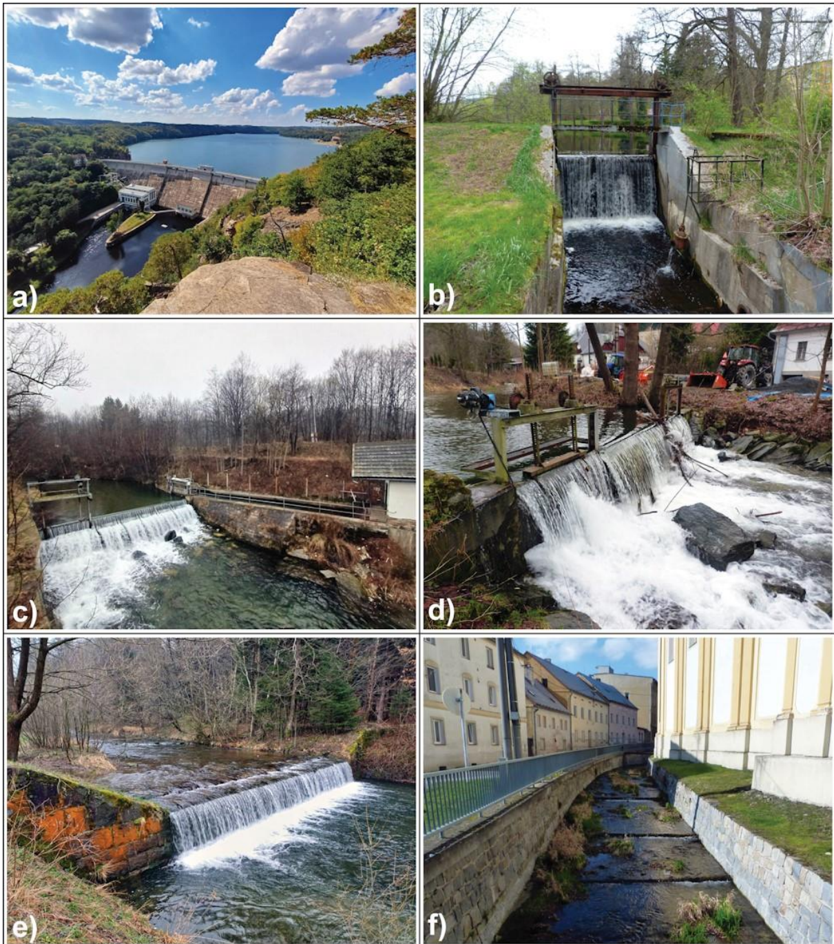
Obr. 8: (a) vodní nádrž – dochází ke změně hydromorfologických parametrů na dlouhých úsecích; (b) výpust z rybníku – rybníky vyvolávají významné zpomalení proudění a narušují transport sedimentů; (c) jez s derivačním kanálem – účelem jezu je vzdouvat vodu k různým vodohospodářským účelům (energetika, odběry vody, plavba...); (d) stavidlový jez – jez s pohyblivými stavidly, v případě jejich zvednutí při povodních je možné snížit vliv jezu na transport sedimentů; (e) stabilizační stupeň – objekt o výšce nad 0,3 m, buduje se pro úpravu podélného sklonu dna po napřímění koryta, účelem stupňů je stabilizovat dno koryta a zabránit zpětné erozi dna, od retenčních přehrázek se liší tím, že nemají zádržný prostor pro zachyt sedimentů; (f) stabilizační prahy – objekty o výšce pod 0,3 m, funkce prahů je stejná jako v případě stabilizačních stupňů
