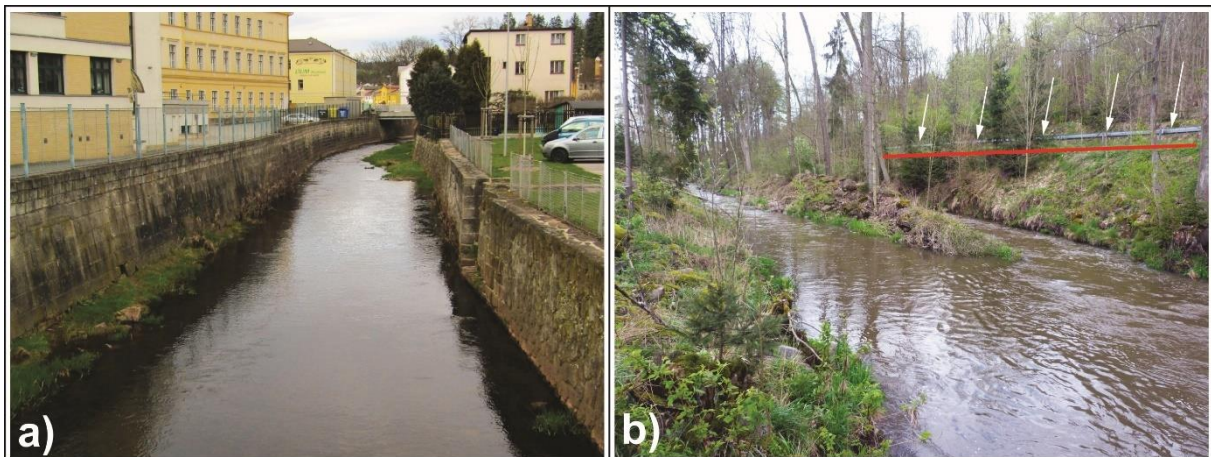
Obr. 12: (a) v zastavěných územích absentuje prostor pro laterální migraci koryta (tzv. erodovatelné inundační území), navíc erozi brání stabilizace břehů; (b) konektivitu údolních svahů s korytem často narušují silnice vedené paralelně s korytem, vodní toky jsou pak ochuzené o sedimenty
