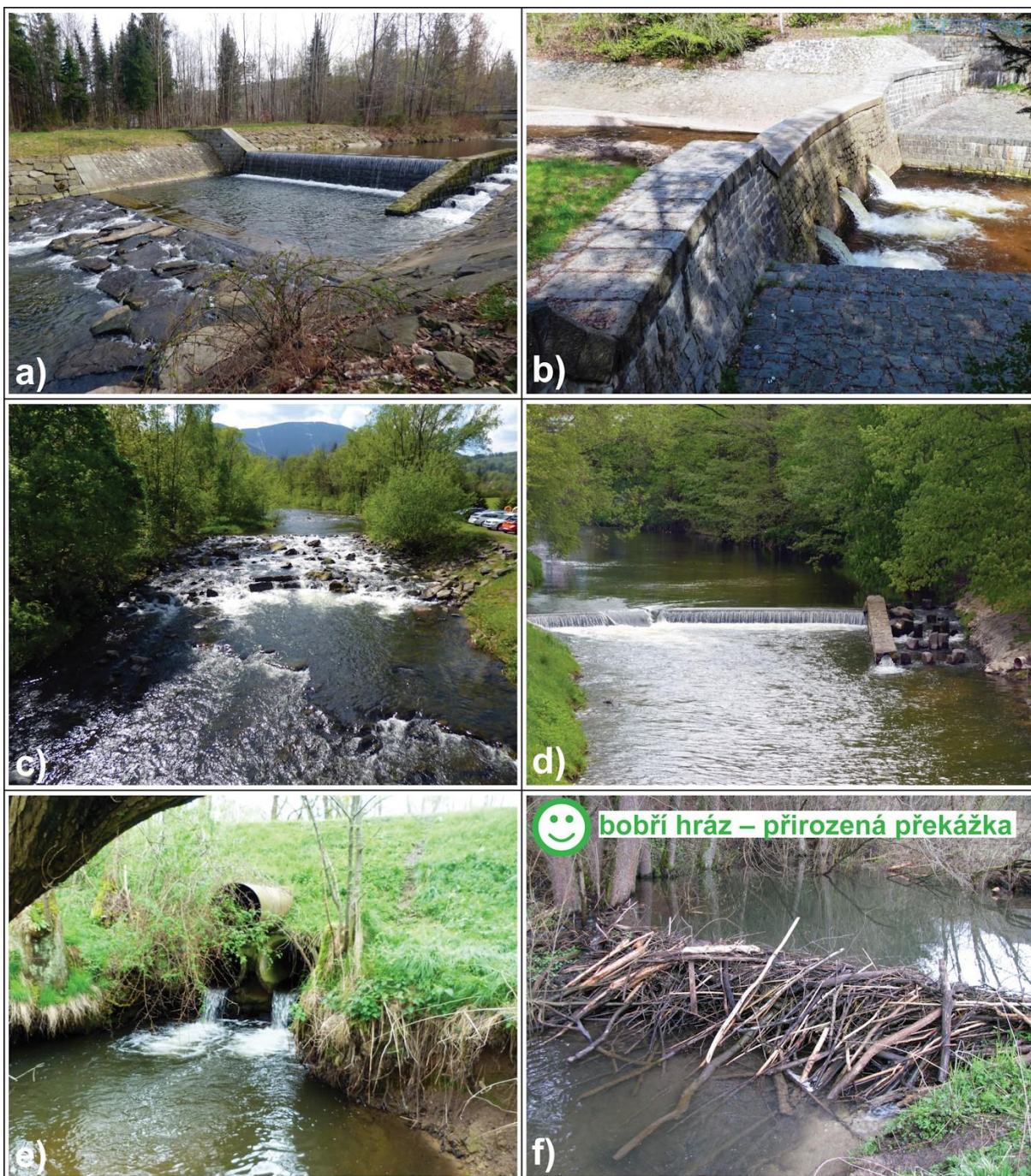
Obr. 9: (a) stabilizační pas (pod stupněm s rybím přechodem) – pasy jsou stabilizační prvky zapuštěné do dna, jejich funkce je stabilizace dna v místě přechodu podélných sklonů nebo v místě změny typu opevnění; (b) retenční přehrážka – jedná se o spádový objekt, jehož hlavní funkcí je zastavit chod hrubých splavenin a akumulovat je v prostoru nad přehrážkou, přehrážky se budují na horských tocích s vysokým sklonem a velkou transportní kapacitou; (c) balvanitý skluz – skluzy jsou spádové objekty, které vyrovnávají rozdíl výšek nivelety dna souvislou plochou, jedná se o způsob úpravy podélného sklonu dna koryta, který se nejvíce blíží přírodním tvarům horských toků; (d) nízký stupeň s balvanitým rybím přechodem – v závislosti na vyskytujícím se rybím společenstvu mohou i poměrně nízké stupně představovat migrační bariéru; (e) trubní propustek – propustky slouží k vedení vody pod silnicemi nebo náspy, velmi negativní vliv na migraci ryb a transport sedimentů mají především trubní propustky; (f) bobří hráze – přirozená překážka na vodním toku, při hodnocení podélné kontinuity se nezohledňuje
